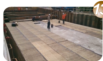
13. 頂版水密處理 -RC 面鋪設油毛氈
