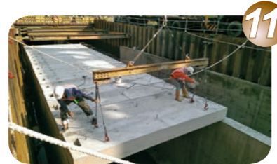
11. 預鑄頂版吊掛 (2)
