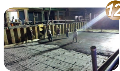
12. 頂版水密處理打設 20 cm 鋼筋混凝土
