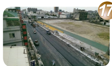
17. 路面 AC 鋪築 (2)
