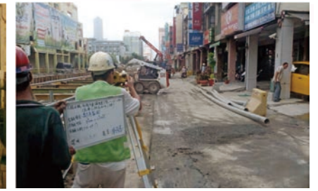
圖 17 鄰房監測 - 沉陷及傾斜觀測
