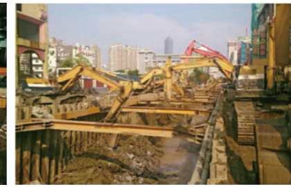
圖 16 全面打除既有毀損箱涵
