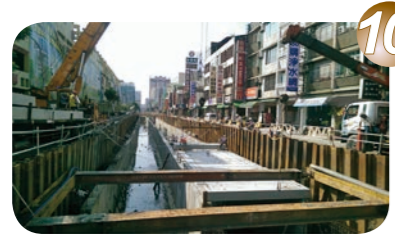
10. 預鑄頂版吊掛 (1)
