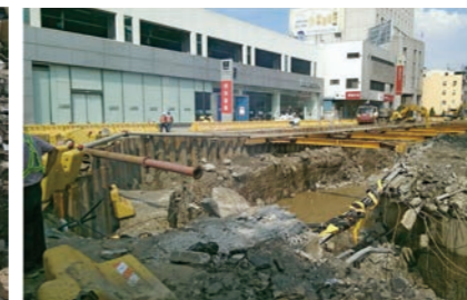
圖 19 晴天或雨量較小時，以機械抽水接力排水
