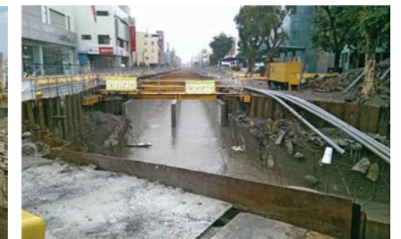
圖 20 雨量較大時，開放箱涵通水
