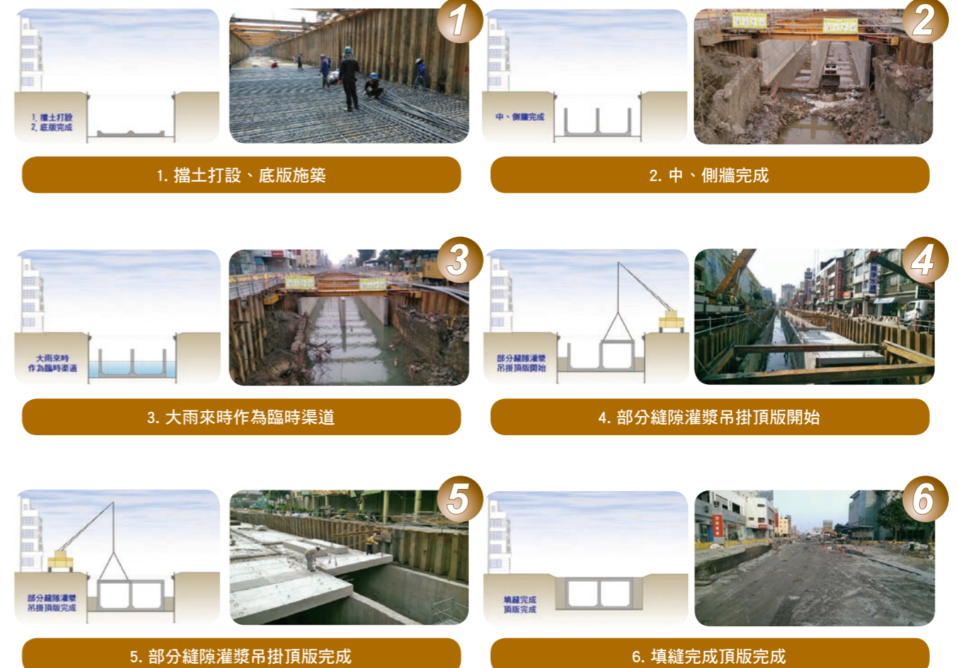
圖 13 預鑄頂版箱涵施工流程
