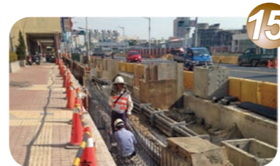
15. 道路側溝及管線埋設
