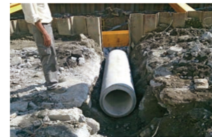
圖 18 路側排水溝銜接開挖斷面
