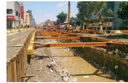
圖 15 打設鋼板樁及架設水平支撐
