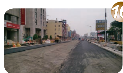
16. 路面 AC 鋪築 (1)
