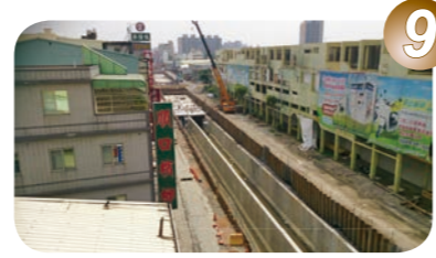
9. 箱涵中側牆完成
